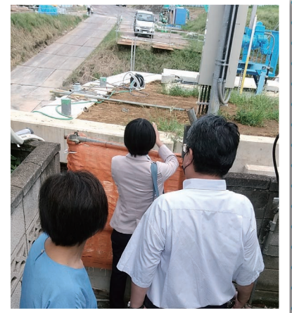
江川第3調節池 工事現場
