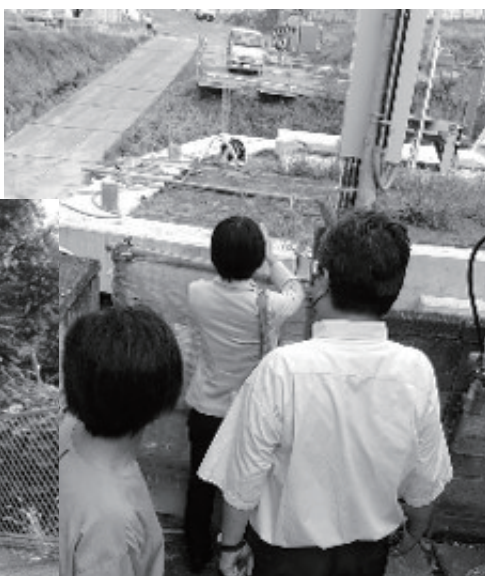
▲江川第3調整池の工事現場
