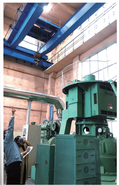
元郷ポンプ場の視察。施 設の耐震化や浸水対応等 の体制を聞く
