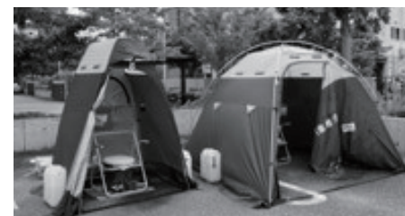
マンホールトイレ
